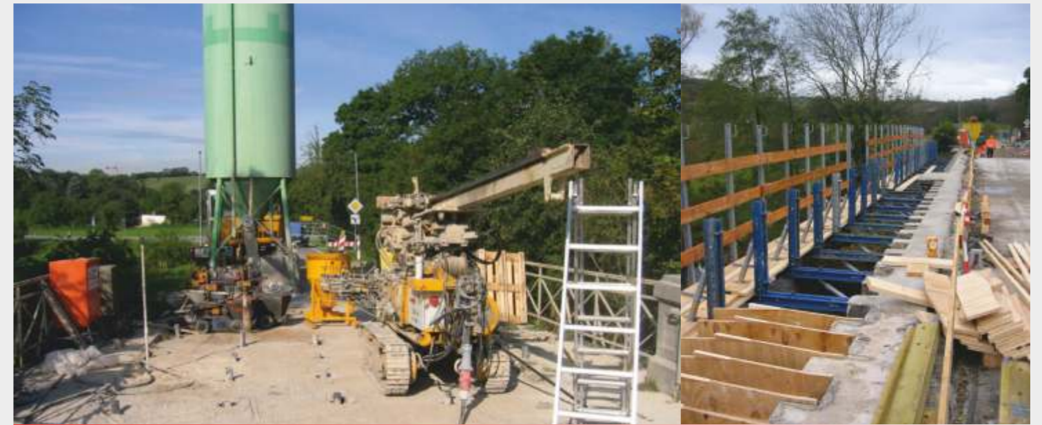
Pfeilerinjektion am BW 0020
