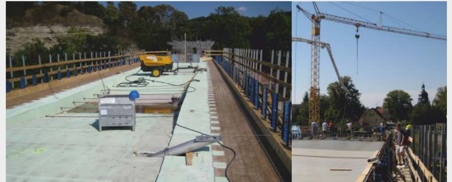
Gewölbe vor dem Einbau der Bewehrung der Fahrbahnplatte am BW 0010
