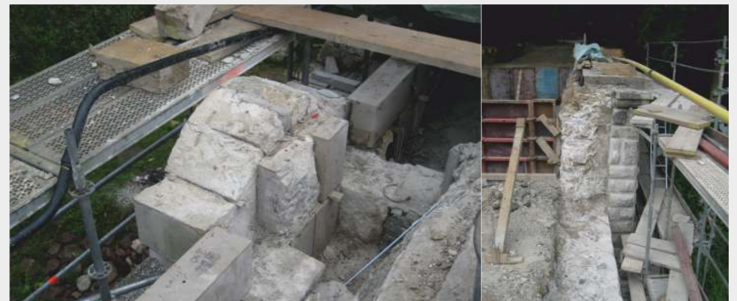
Stirnmauerwerk mit Bruchsteinbetonhinterfüllung am BW 0030
