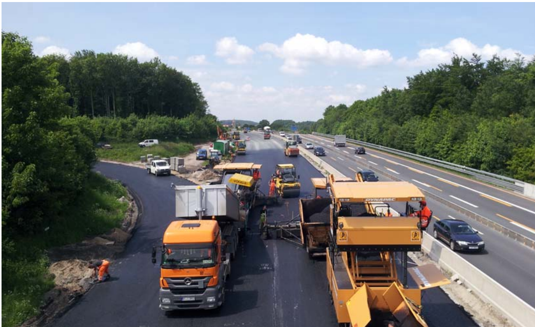
Einbau SMA 11 S Richtungsfahrbahn Bad Oeynhausen
