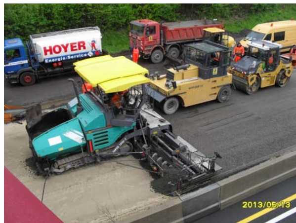
Einbau Asphaltfundationsschicht
